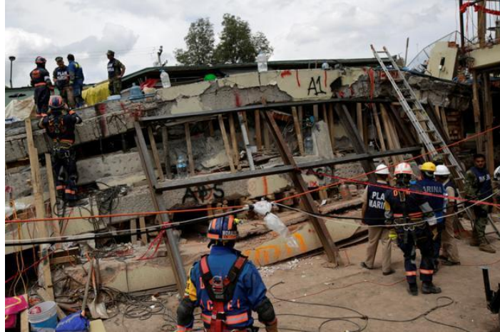
Figura 1. Terremoto de 2017, Ciudad de México.
